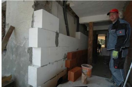
Mineralschaumplatten samt Vormauerung nach Durchtrennung der nördlichen Stahlbetondecke
