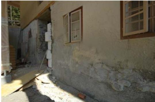
trocken gelegte Außenwand vor Herstellung der Außendämmung
