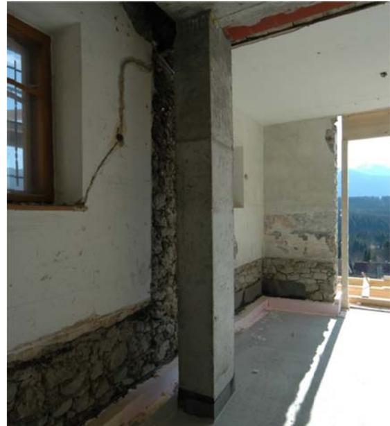
neue Decke und Stütze, 30 cm von Außenwand getrennt.
