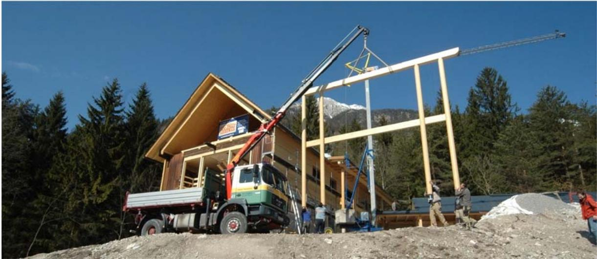
Die Montage der südseitigen Balkon- bzw. Terrassenkonstruktion aus Lärchenholz - 21.03.11
