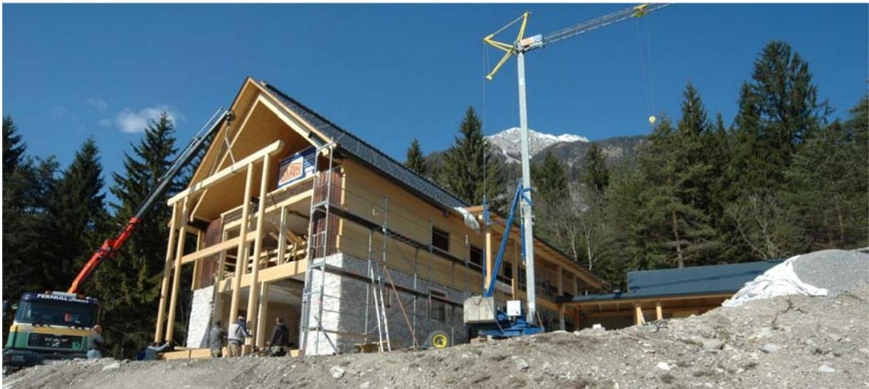
An der ostseitigen Holzriegelwand wurden bereits die außenliegend. Holzweichfaserplatten montiert – 21.03.11
