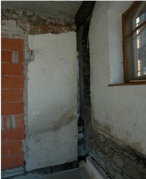
Durchtrennung Innen-/Außenwand für die 30 cm starke Innendämmung
