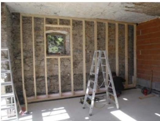
Tragende Holzvorsatzschale für die 30 cm starke Innendämmung aus Isocell
