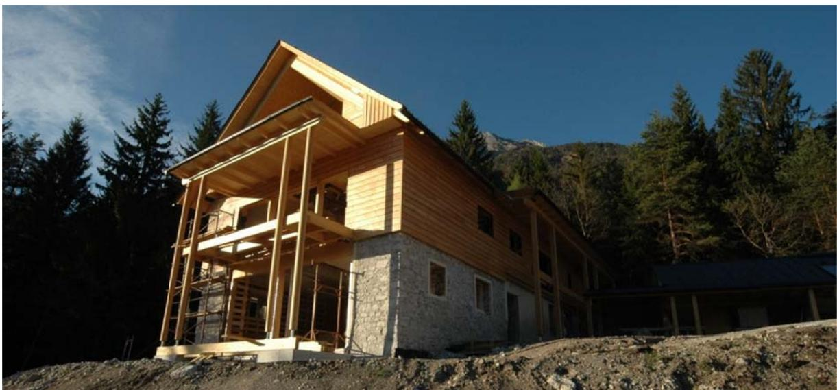
Südostansicht–neue Fassade mit Hinterlüftung und horizontalen Lärchenbrettern u. Balkonkonstruktion – 08.04.11
