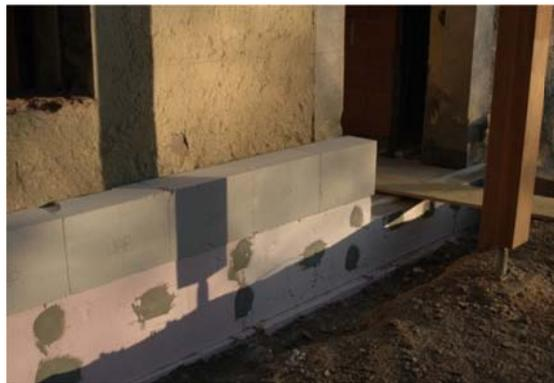
die 26 cm starke Außendämmung wird 70 cm unter Terrain geführt. Unter Niveau werden die Mineralschaumplatten durch XPS-Platten ersetzt. Unterhalb der XPS Platten wurde ein Unterbeton hergestellt, damit das Auflager für die Wand gegeben ist. Der Übergang zwischen XPS und Mineralschaumplatte befindet sich exakt in der Null-Ebene um Rissebildungen im Sichtbereich zu vermeiden.
