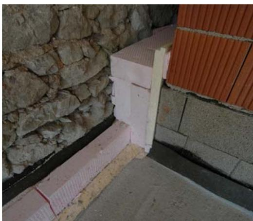
30 cm Innendämmung im Fußbodenbereich
