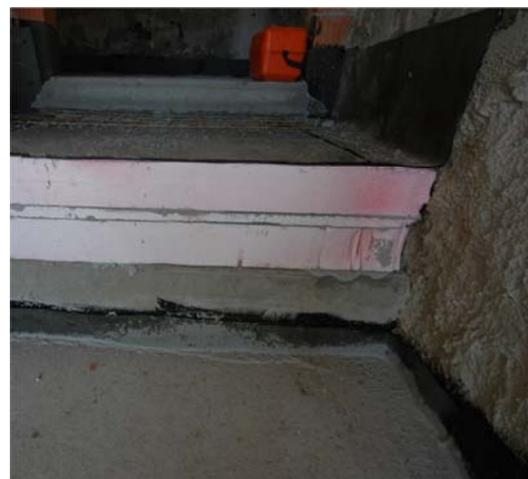
Fußbodendämmung 24 cm XPS-Platten unterhalb des Unterbetons
