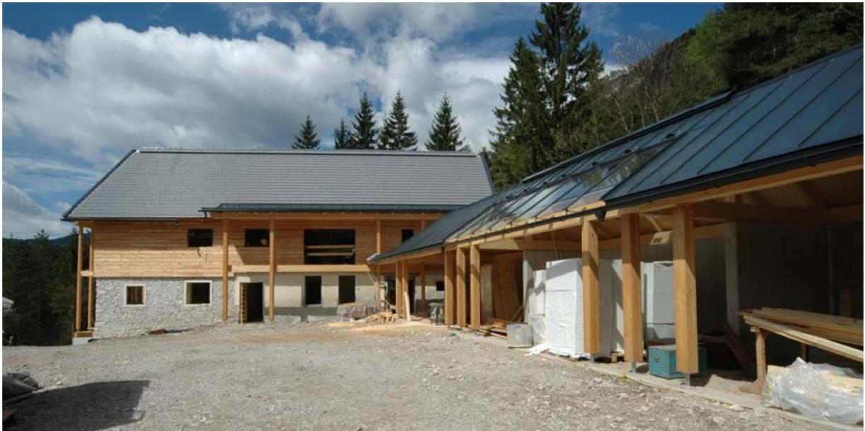
Das Glashaus wurde leicht in die Südrichtung geschwenkt. Um eine fast reine Südorientierung für die südliche Dachfläche zu erhalten und damit der Schlagschatten der Abendsonne des Hauptgebäudes so spät wie möglich auf die Dachfläche der Photovoltaik fällt. Die Kollektoren werden oberhalb der Blecheindeckung mit Hinterlüftung montiert.
